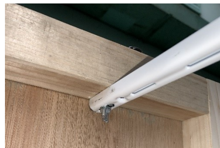
C – Fixation des traverses « T » entre chaque poteau (étape 8)
