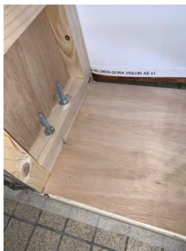
A– Papillons à resserrer avant le démarrage de l'installation
