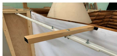
E – Fixation des tasseaux de renfort des bâches (étape 20)
