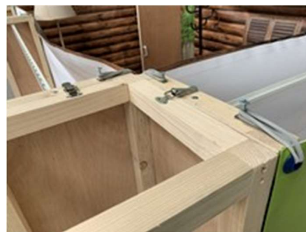
B – Fixation des poteaux entre eux (étapes 4, 6 et 7) et des élastiques des bâches (étape 19)
